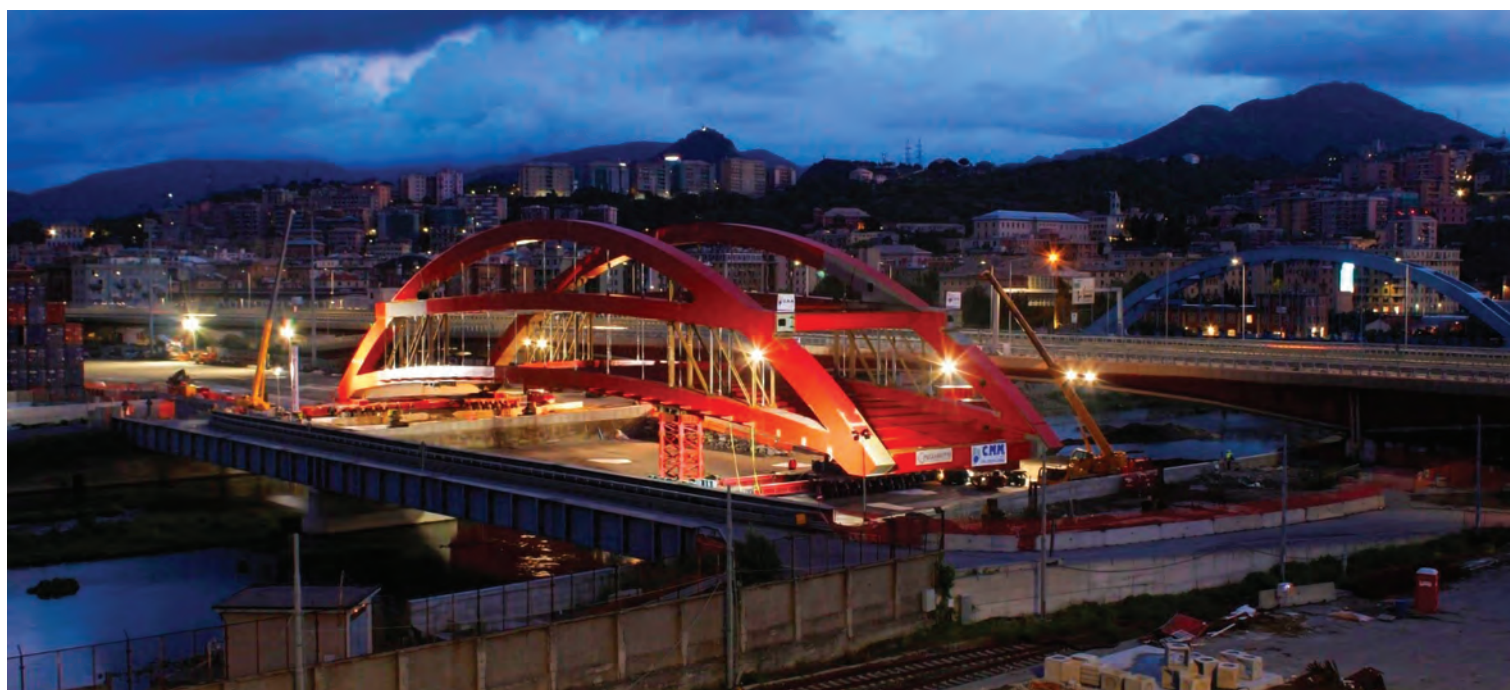
Figura 18 | Foto della porzione ad arco centrale durante le fasi di attraversamento del fiume Polcevera
