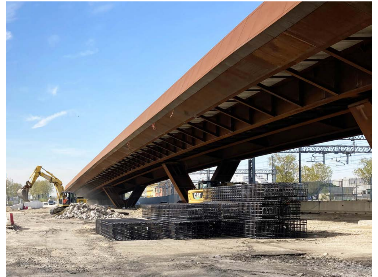
10. Viadotto principale completato
