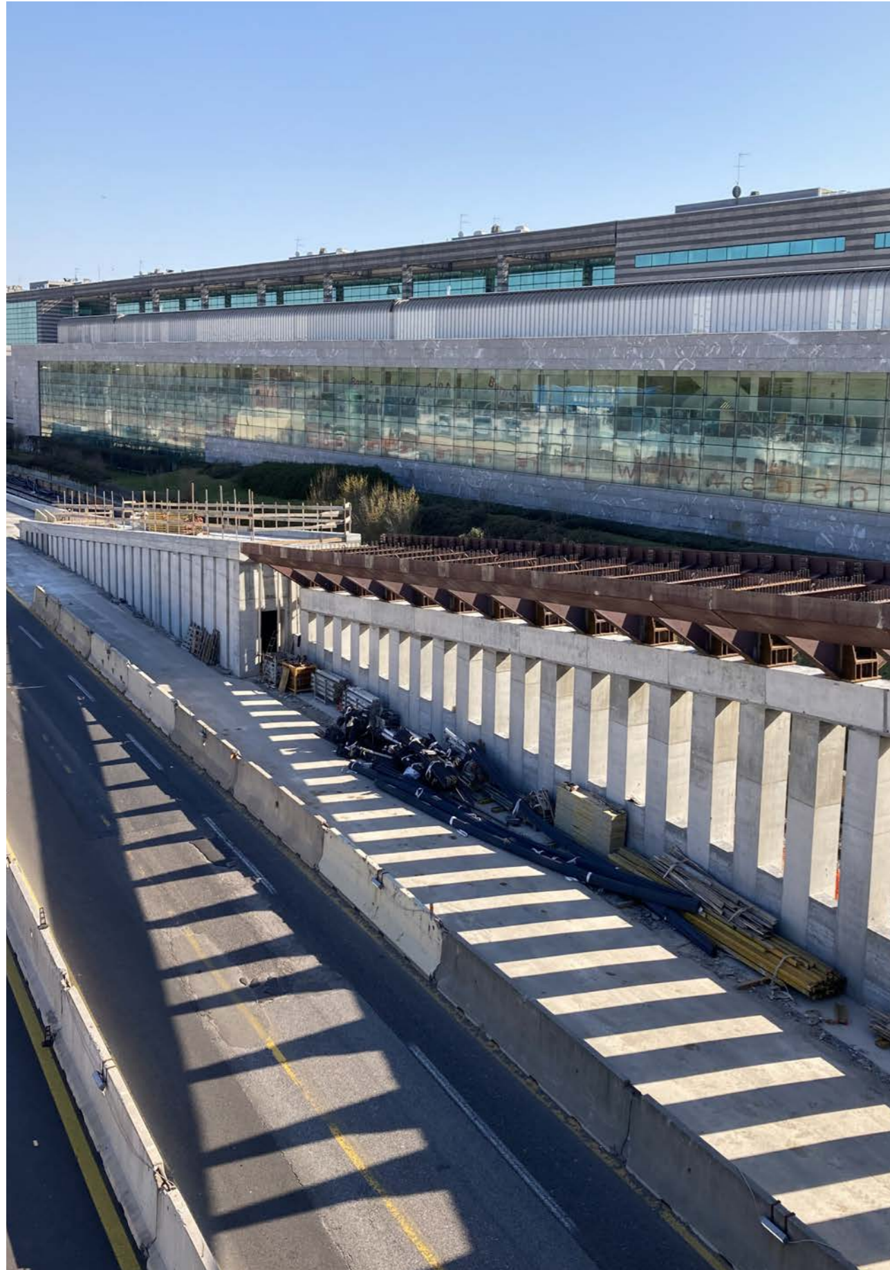
18. Posa della carpenteria metallica - Viadotto asse secondario lato Venezia
