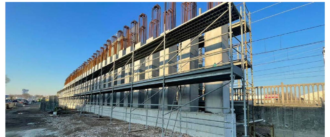
32. Montaggio ponteggio per realizzazione trave di sommità della galleria
