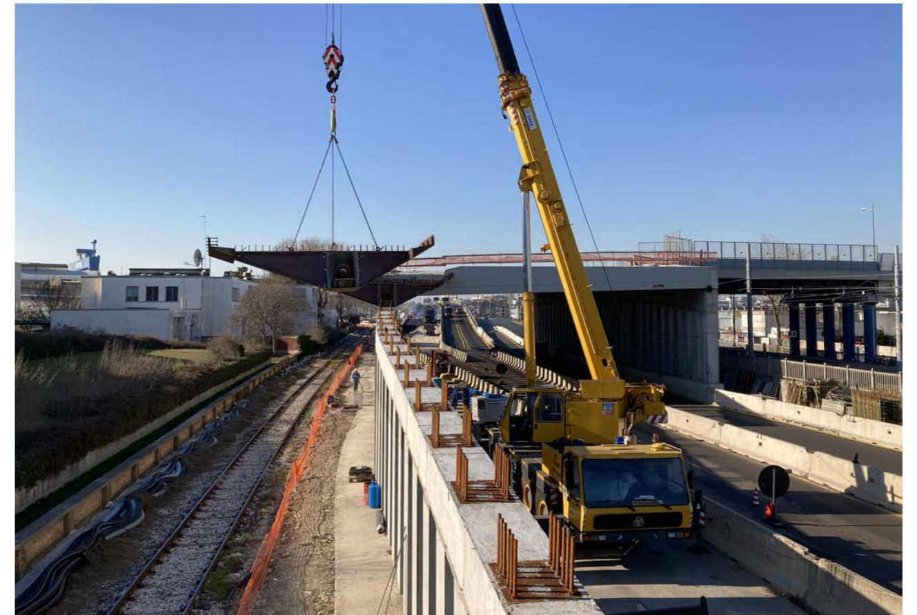
16. Assemblaggio Viadotto asse secondario lato Venezia
