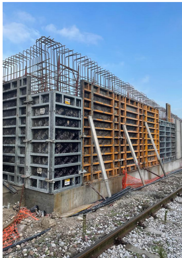
11. Casseratura e successiva scasseratura muro cassone Est, Viadotto secondario
