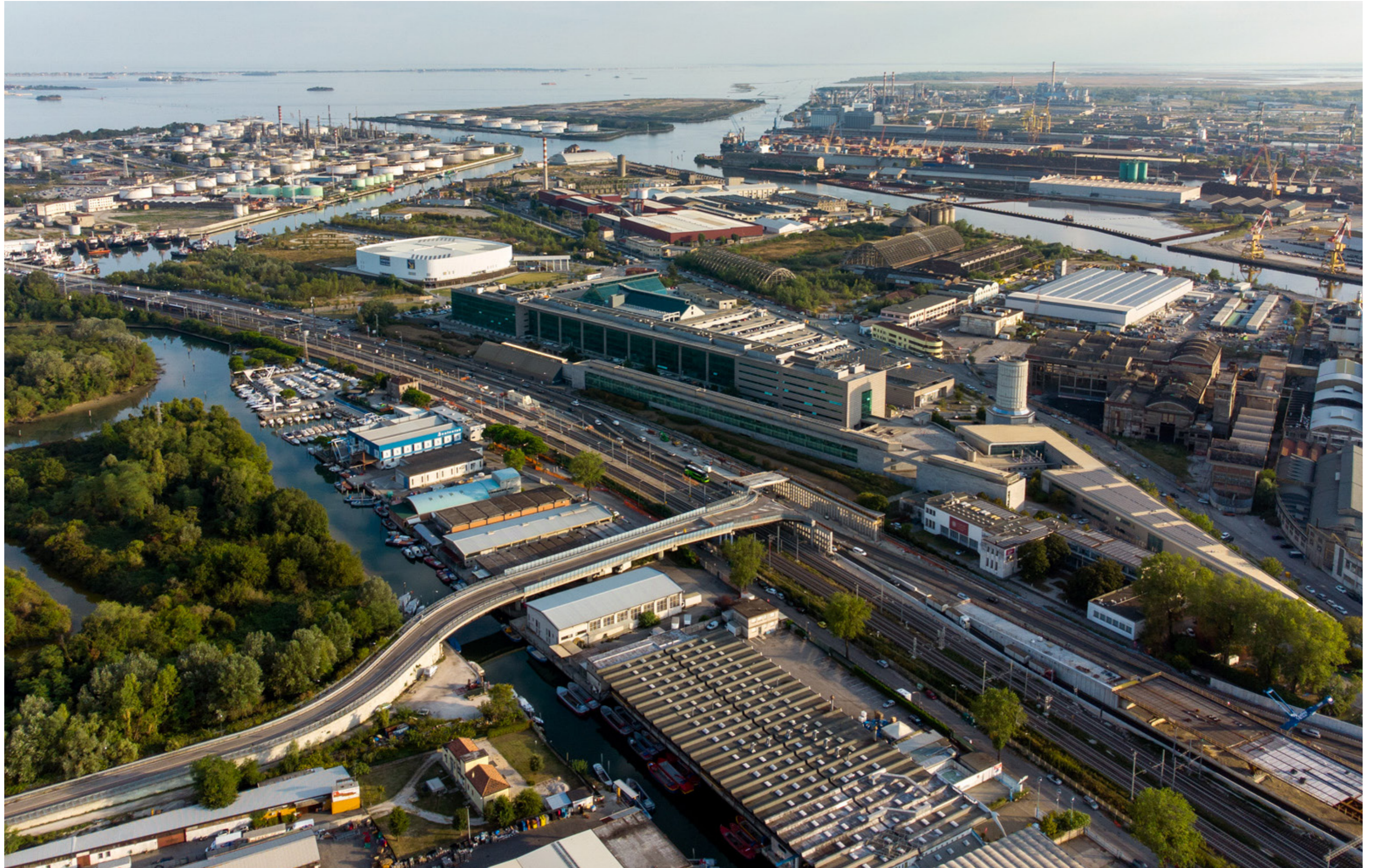
36.- Vista aerea di cantiere: varo delle travi della galleria - © Brussi Costruzioni srl
