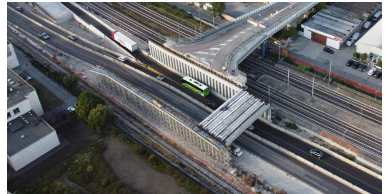
12. Sezione galleria e varo travi galleria
