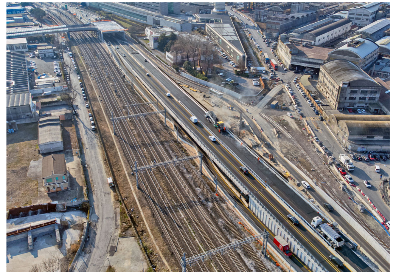
49. Temporanea deviazione del percorso a 2 corsie in direzione Venezia sulla carreggiata nord dell'asse principale ed deviazione del percorso di ritorno da Venezia ad una corsia sulla rampa adiacente alla nuova recinzione ferroviaria - © Brussi Costruzioni srl
