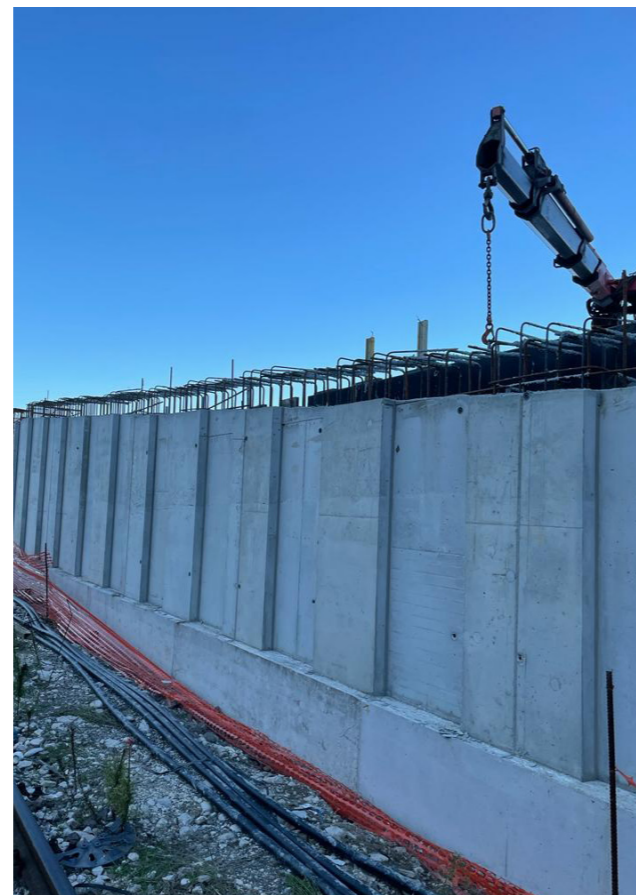
11. Casseratura e successiva scasseratura muro cassone Est, Viadotto secondario
