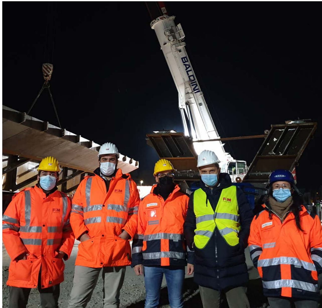
50. Sopralluogo del team F&M durante il varo del primo concio della prima campata del nuovo viadotto
