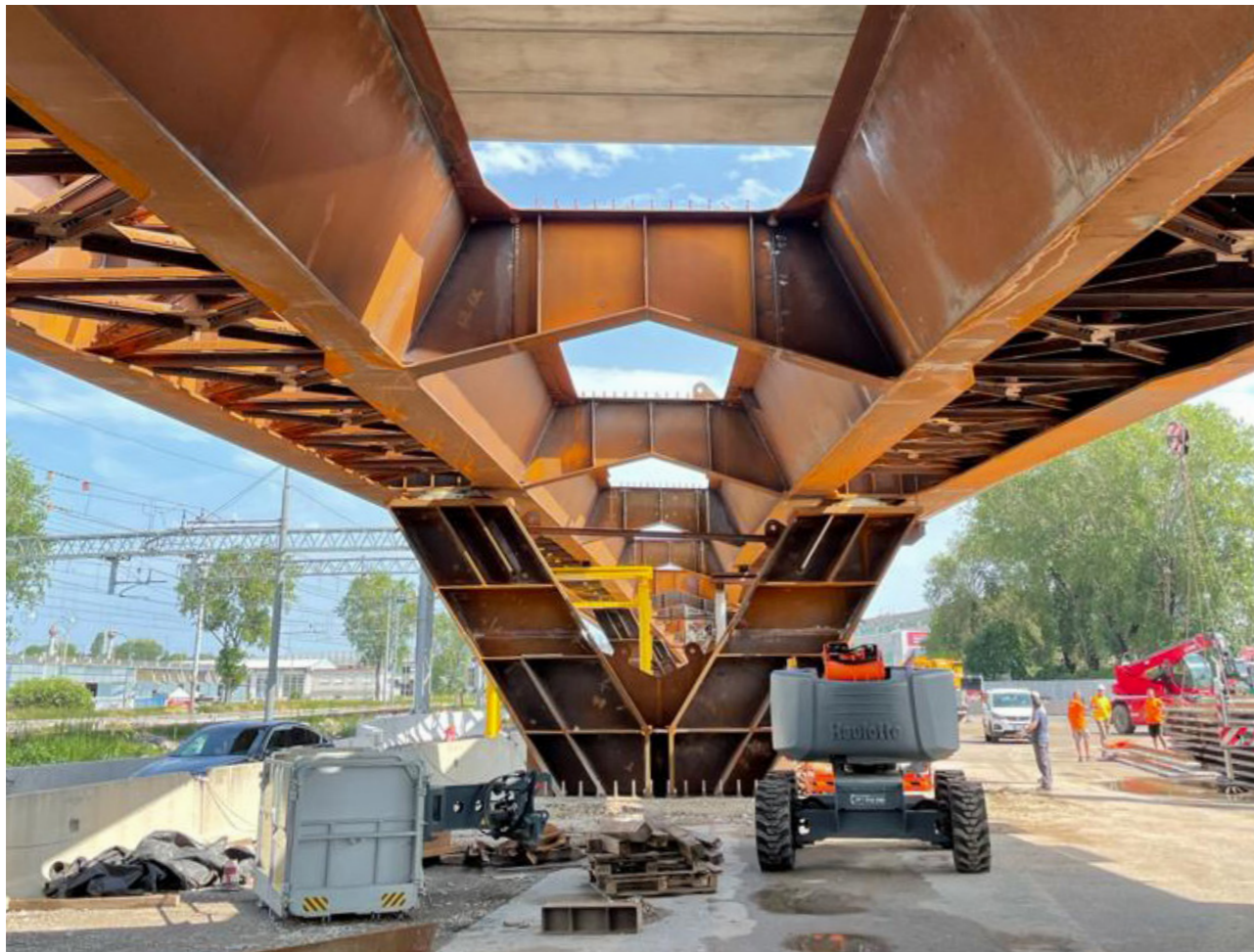
9. Viadotto principale in fase di montaggio
