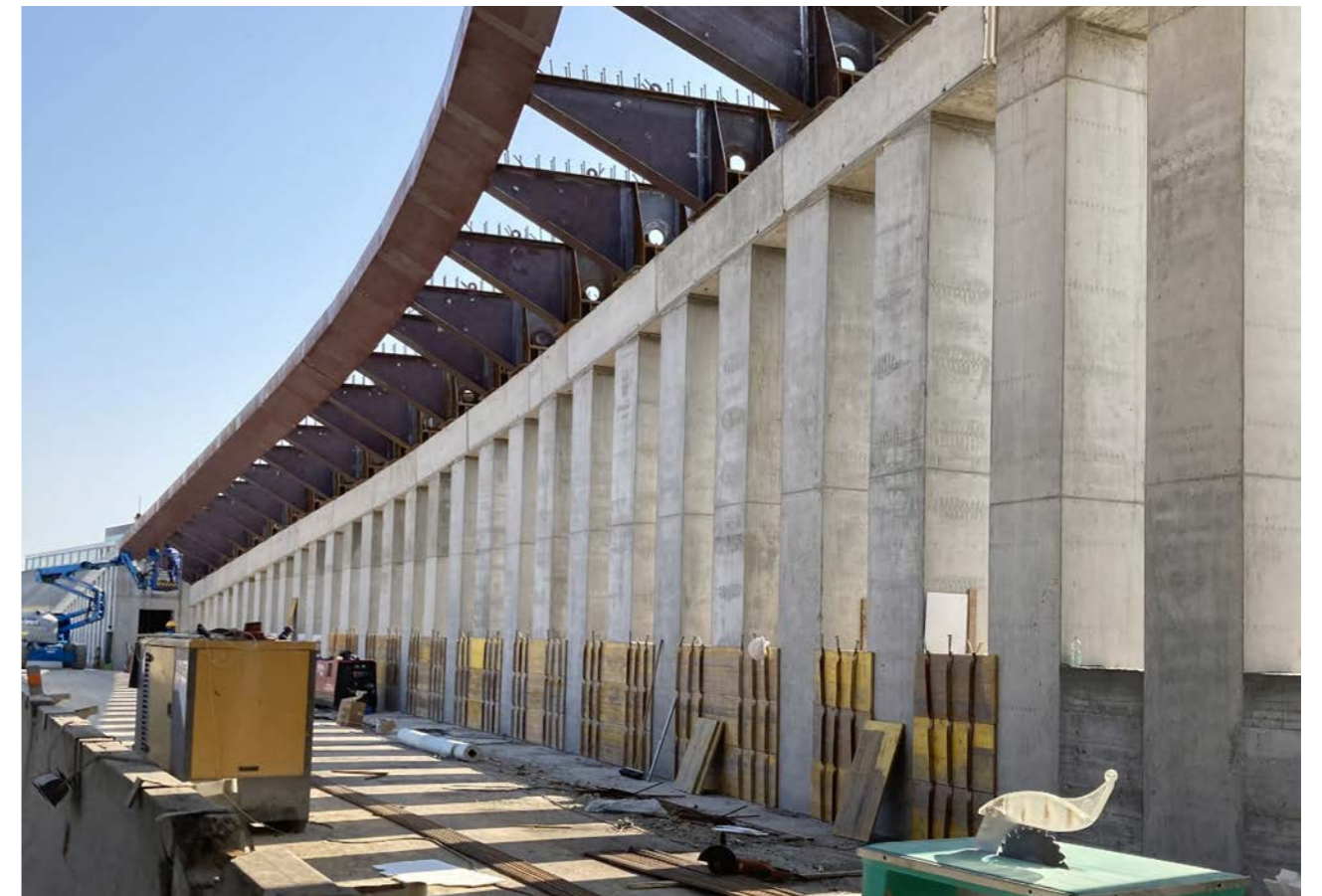
17. Pilastrini e trave continua in c.a. che sostengono l'impalcato in struttura mista acciaio-calcestruzzo
