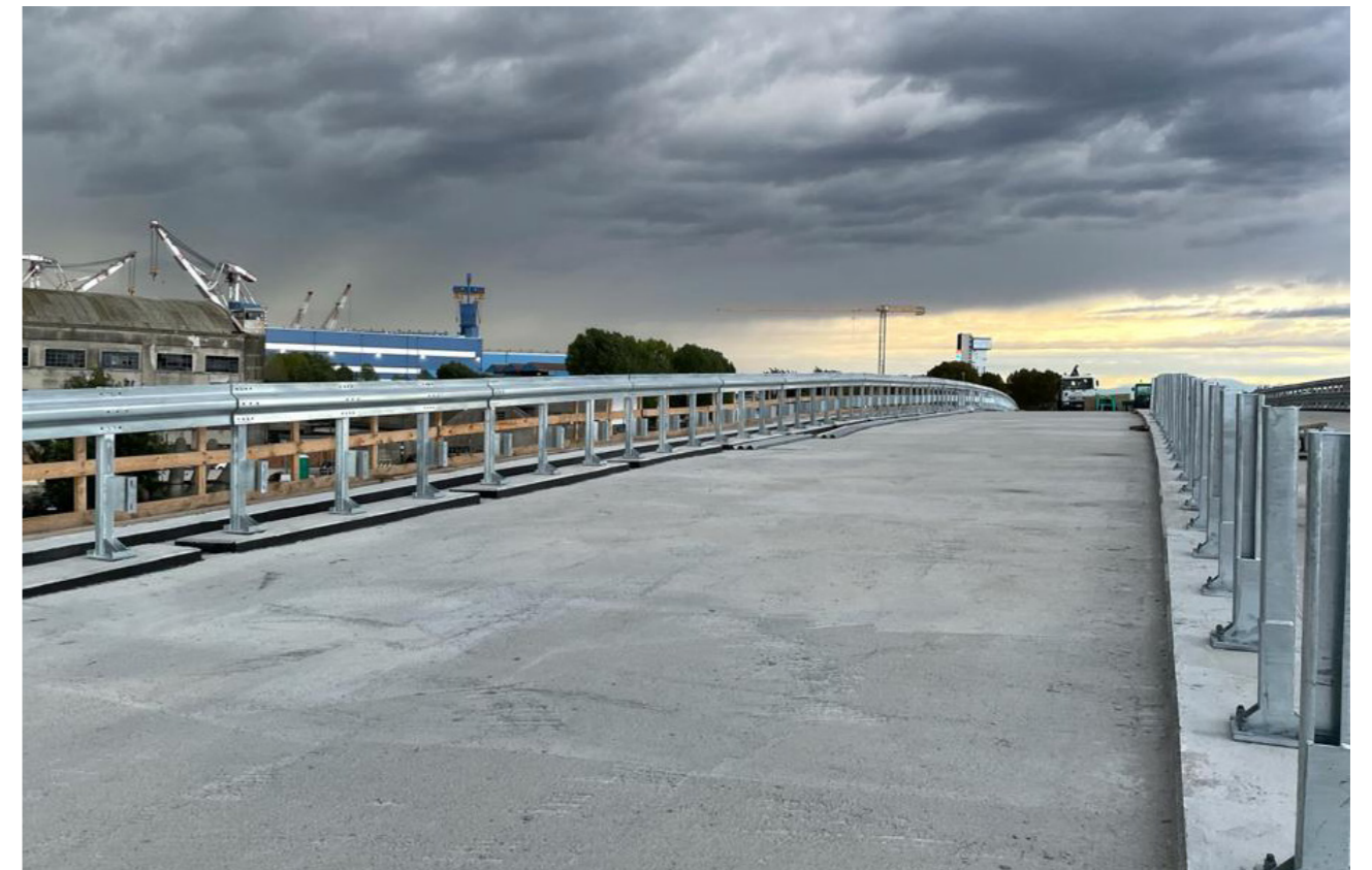
45. Montaggio barriere di sicurezza viadotto
