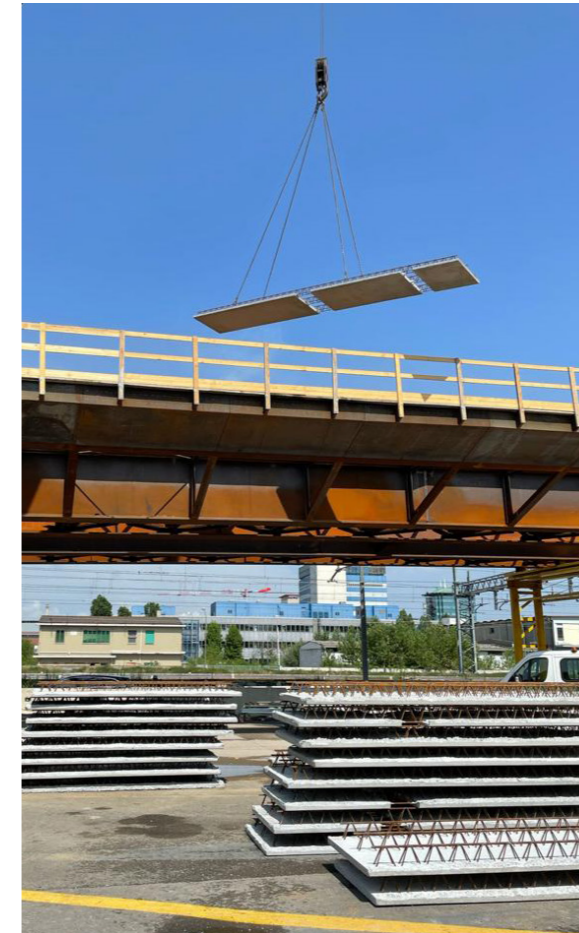
44. Sollevamento e posa delle lastre predalles sopra il viadotto
