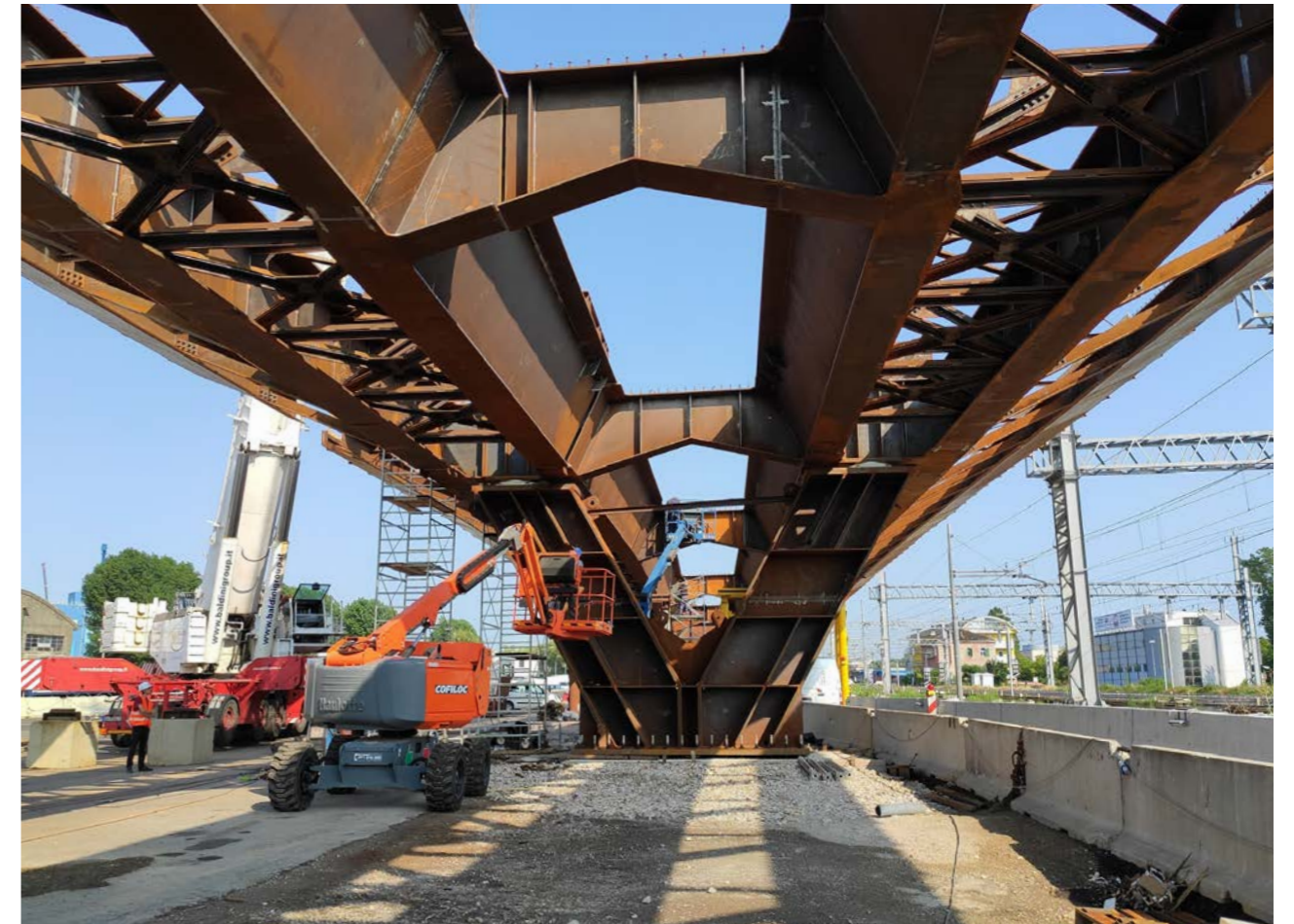
42. Montaggio prima campata lato RFI
