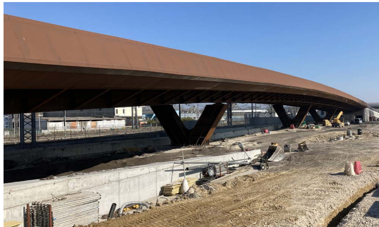
48. Completamento delle strutture del viadotto
