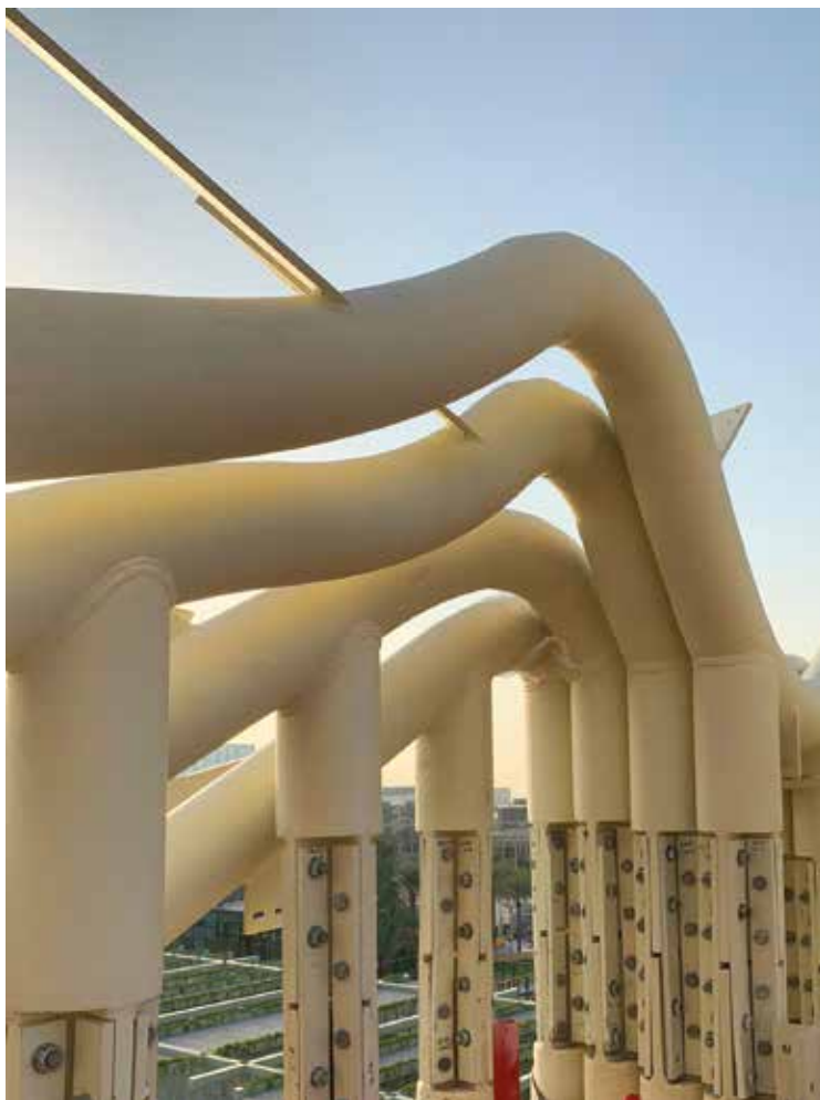
Fig. 6 | Colonne affiancate ai vertici del padiglione e giunzione archi-colonne
