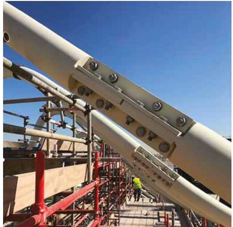
Fig. 13 | Giunzione tra archi e catenarie
