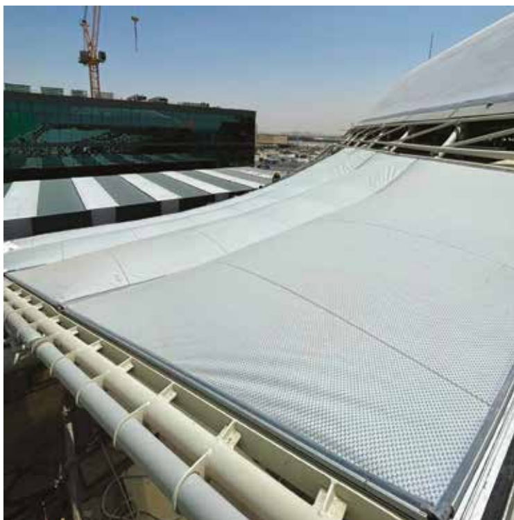
Fig. 21 | Cuscini in ETFE in fase di installazione
