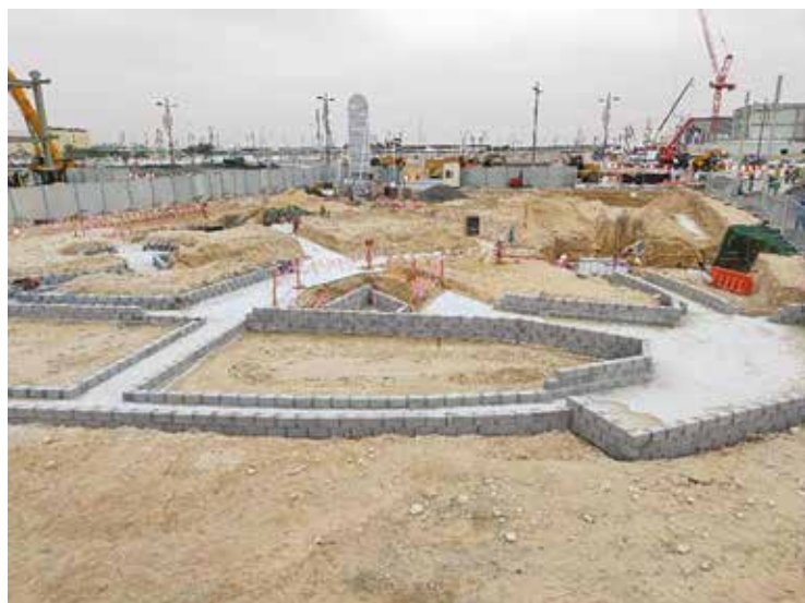
Fig. 22 | Strutture di fondazione in fase di esecuzione
