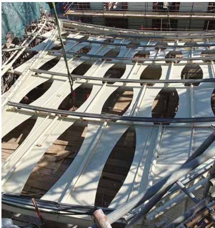
Fig. 15 | Collegamento trasversale delle catenarie mediante aste incernierate e celate dietro la lamiera
