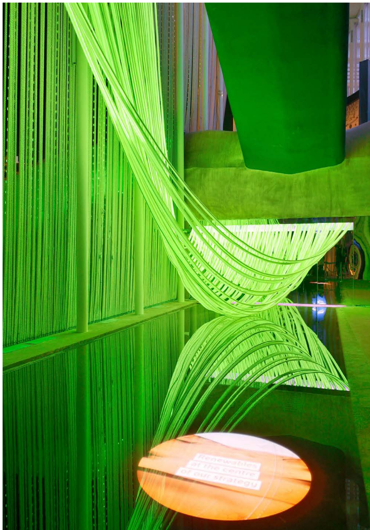
43. Il sistema di facciata con LED incorporati nelle corde nautiche visto dall'interno del Padiglione
