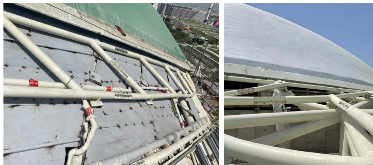
28. Trave reticolare irrigidente ed impianti nascosti dentro i gusci
