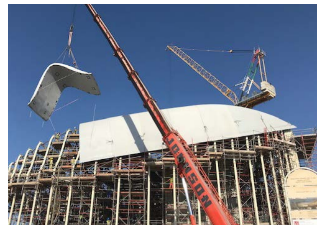
56. Fasi di montaggio degli scafi in copertura
