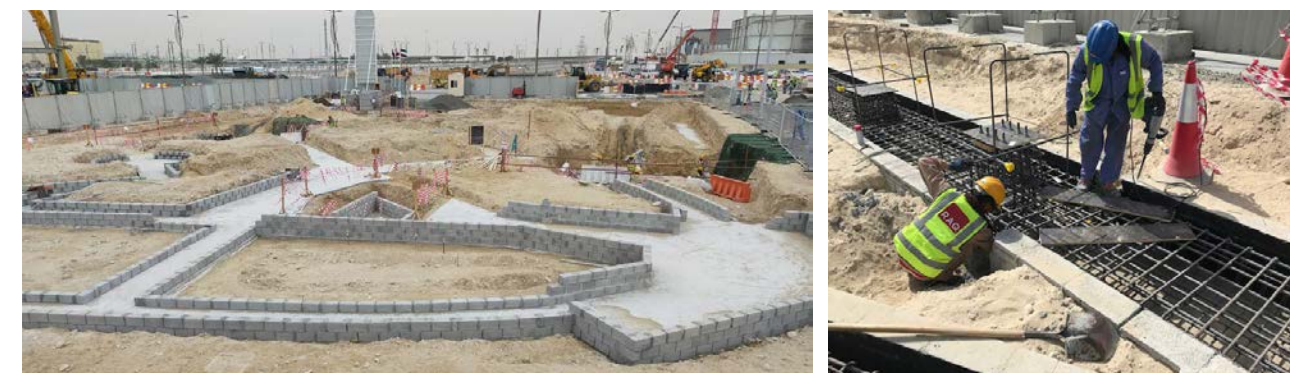
31. Strutture di fondazione in fase di esecuzione
