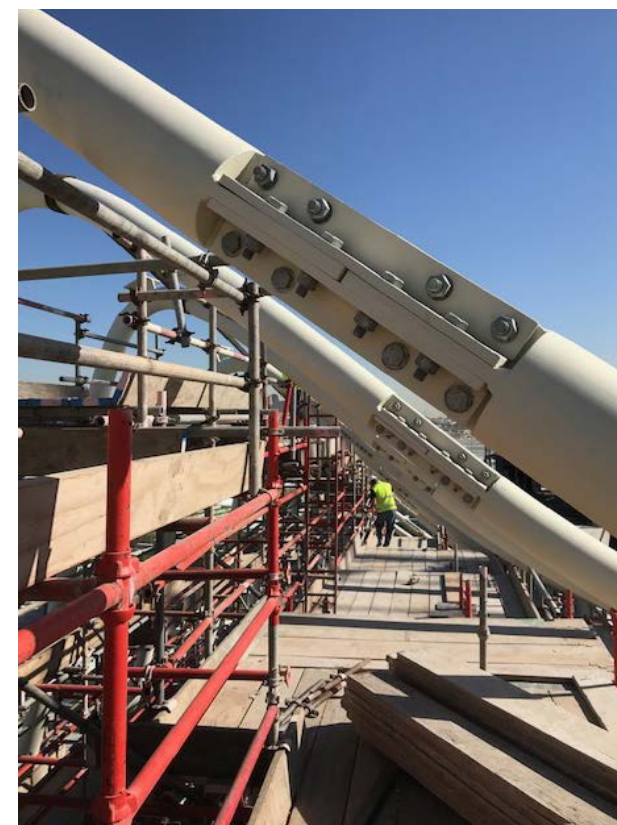
23. Giunzione tra archi e catenarie
