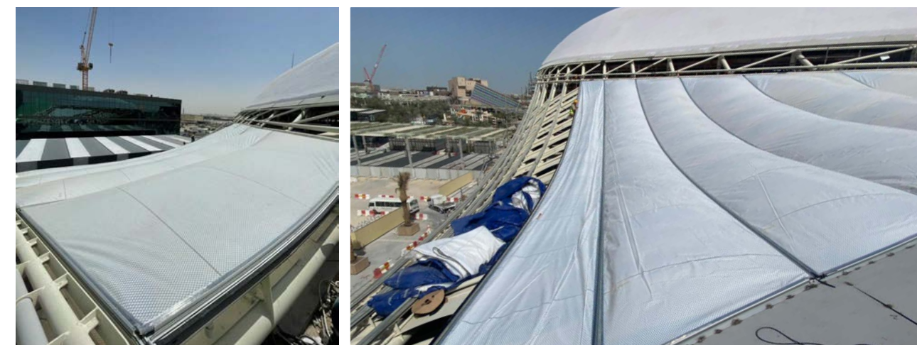
30. Cuscini in ETFE in fase di installazione
