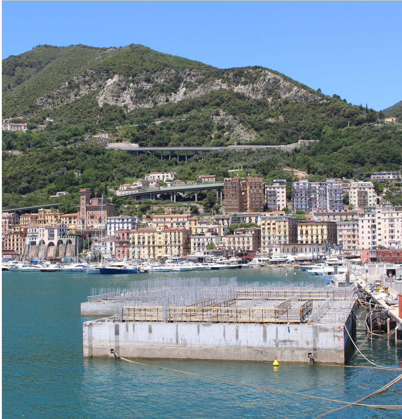
20. Il primo cassone cellulare prefabbricato tipo REWEC3®
