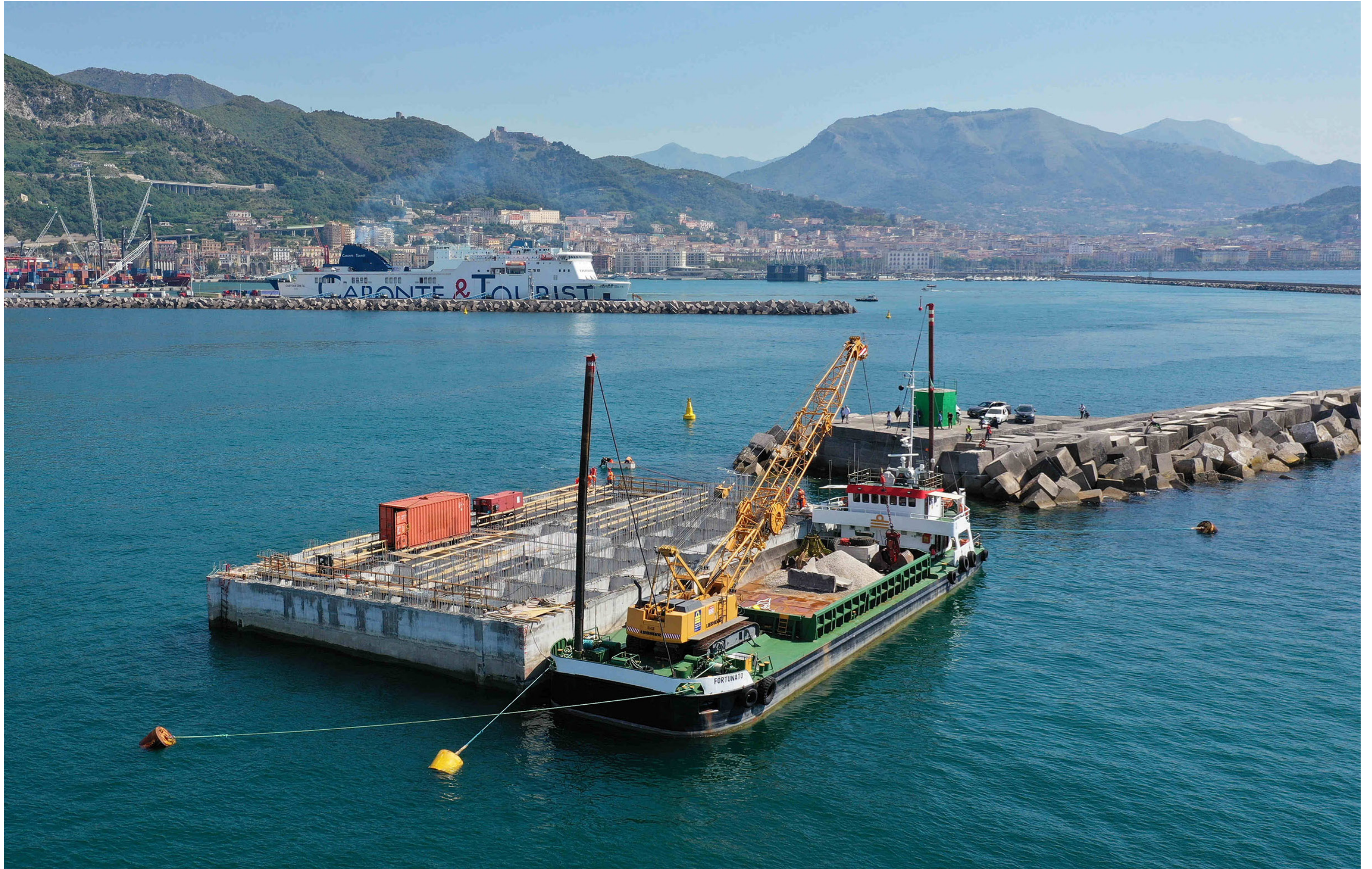
13. Varo del primo cassone cellulare - © Photo by Francesco Pecoraro
