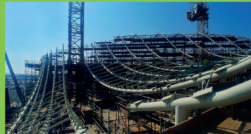
Padiglione Italia, Expo 2020 - Dubai, UAE Dettaglio della struttura di copertura.
