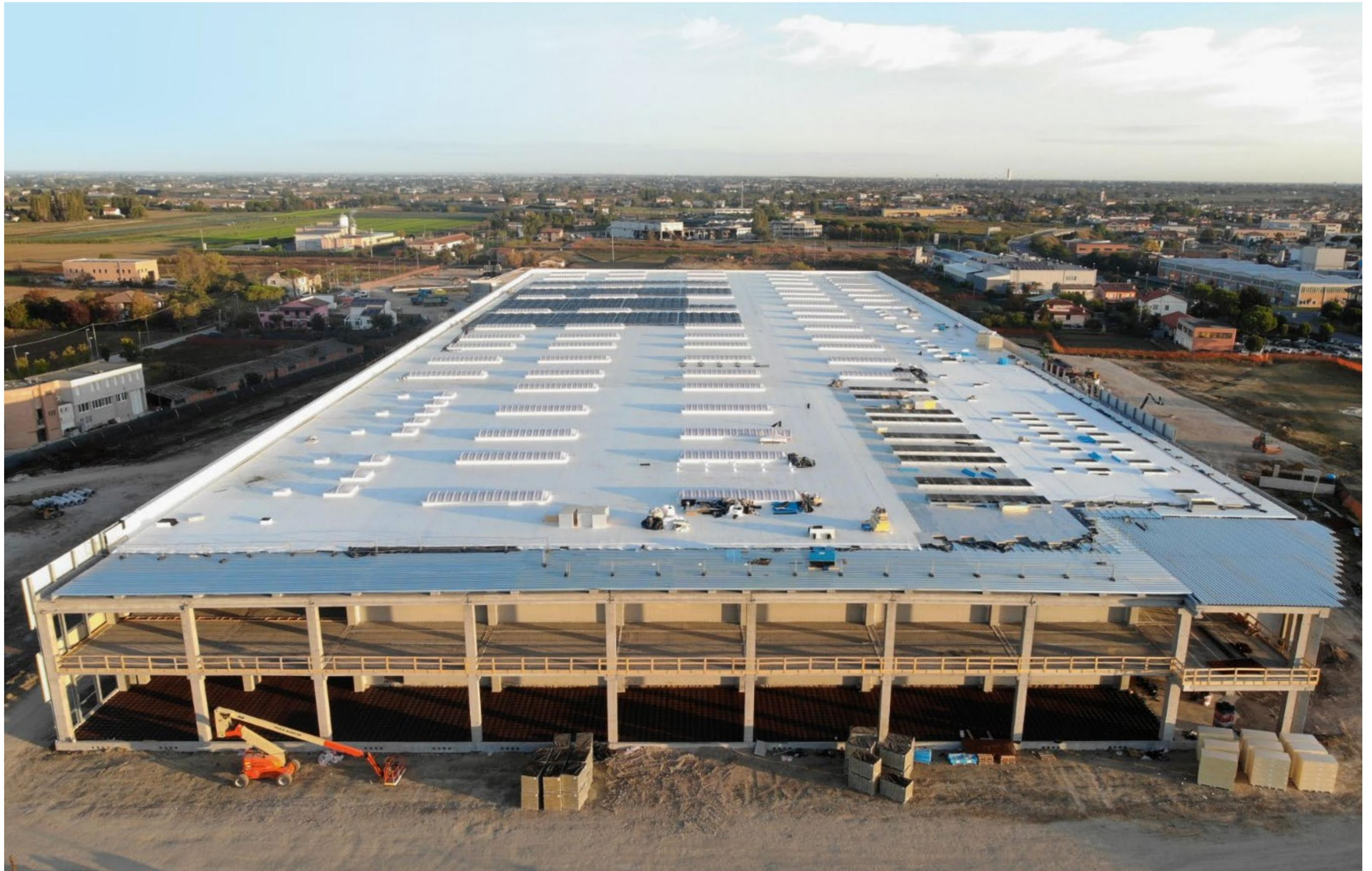
11. Vista sud dello stabilimento: installazione dell'impianto fotovoltaico in copertura
