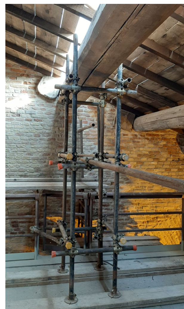
25. Rinforzo del solaio ligneo esistente
