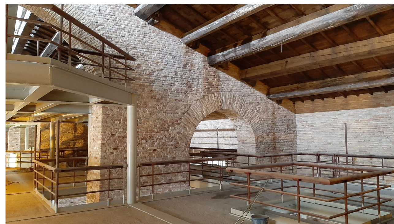
24. Il piano primo indipendente dalla struttura portante
