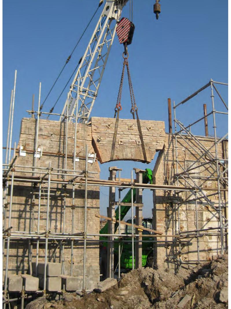
Le murature ottocentesche sono state rimosse, depositate in un'area adiacente al cantiere e successivamente ripristinate dopo la realizzazione dei livelli interrati
