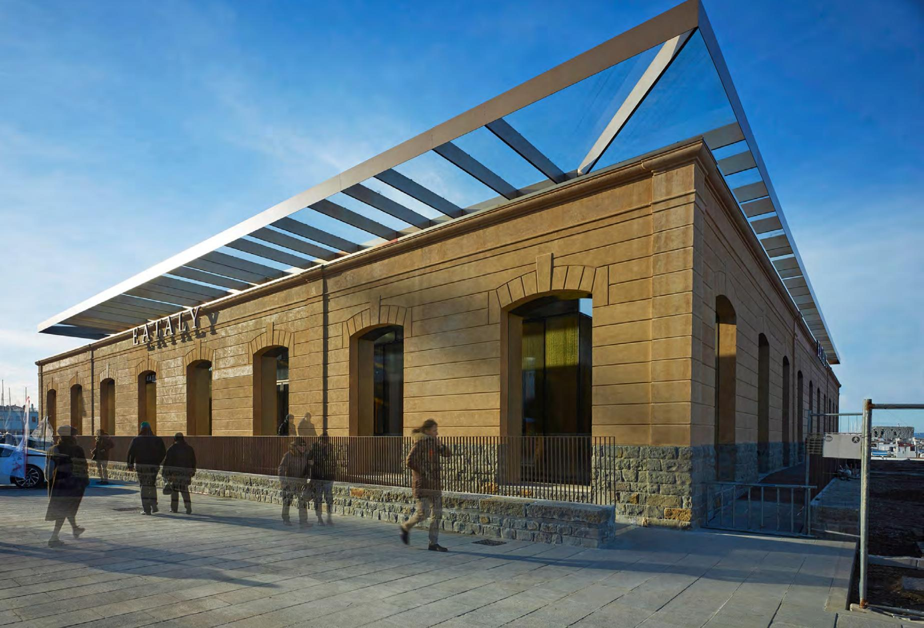
Suggestione e innovazione. Il nuovo punto vendita di Eataly a Trieste realizza un progetto di restauro che letteralmente scava un nuovo edificio - etereo, traslucido e completamente indipendente - all'interno dell'Ex Magazzino Vini. Le mura ottocentesche dell'edificio originario non vengono modificate, mentre il nuovo volume si sviluppa su quattro livelli
