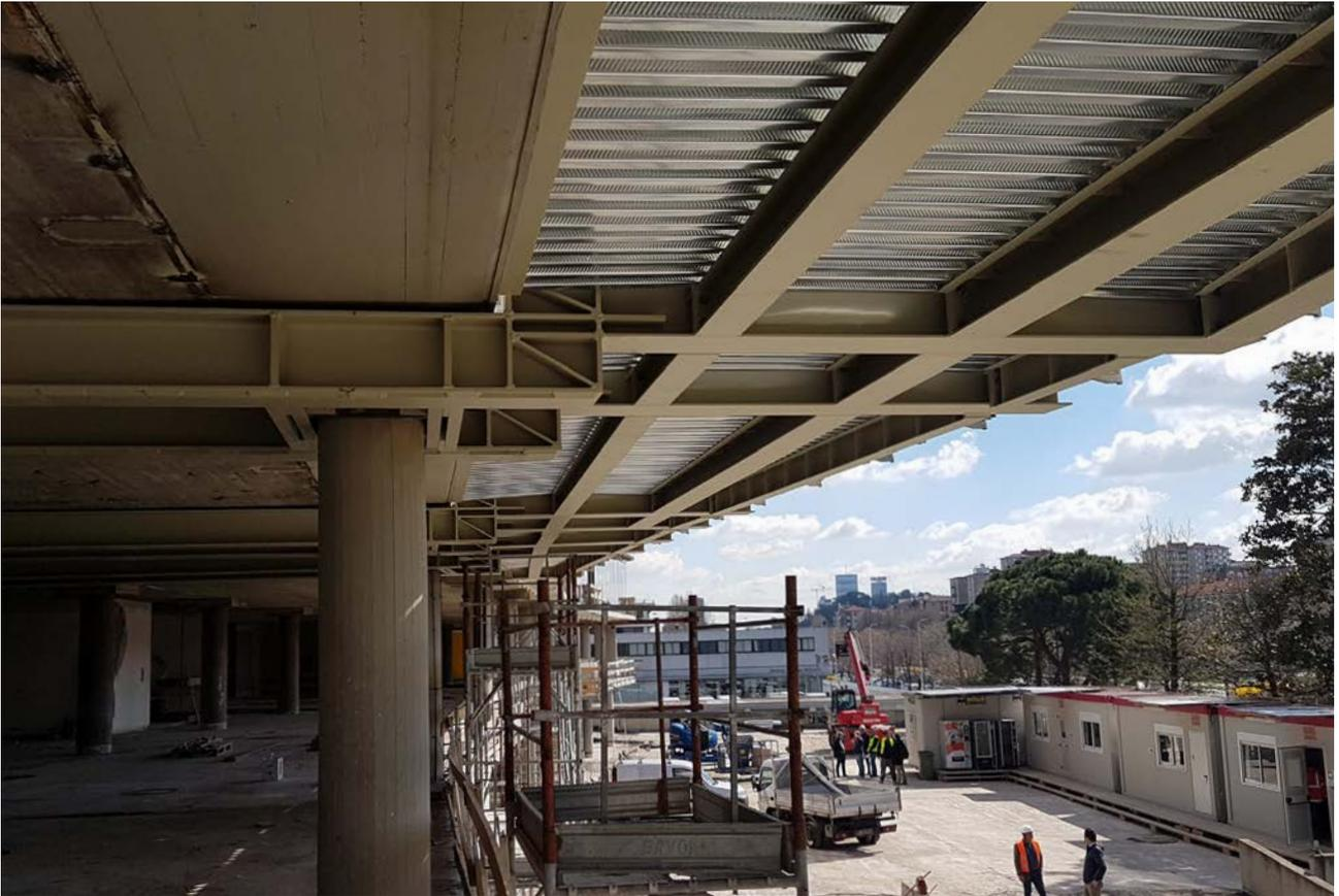
8. I nuovi aggetti con struttura leggera in travi in acciaio
