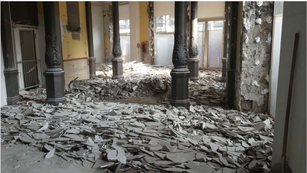
15. Strip out al piano terra, messa a nudo delle colonne in ghisa coeve alla realizzazione dell'edificio e mantenute nel nuovo layout interno
