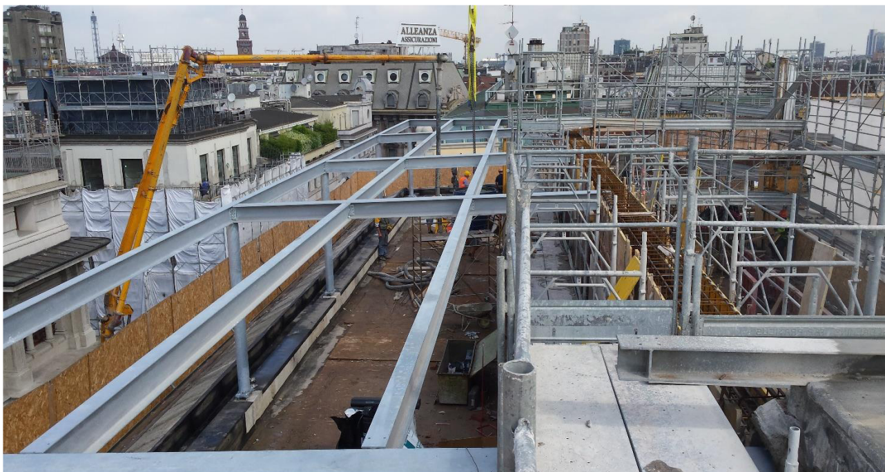
16. Realizzazione della nuova struttura in copertura destinata ad uffici
