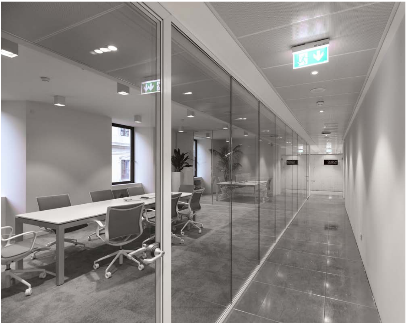
25. Interno di una sala riunioni attrezzata completa di finiture e di arredi tecnici. La suddivisione tra spazio servente e spazio servito avviene attraverso pareti vetrate in grado di rispondere ai criteri acustici specifici per gli ambienti a uso ufficio. La personalizzazione degli ambienti potrà esser svolta dal tenant a seconda dei propri parametri - © Lorenzo Bartoli per Saint-Gobain Gyproc
