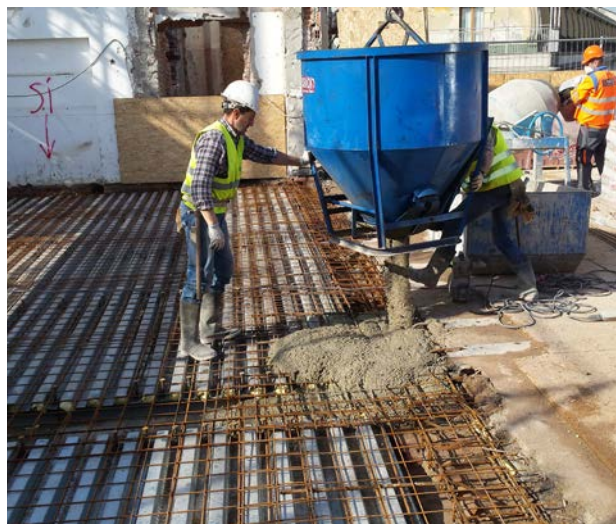
11. Ricostruzione di solai in acciaio dove non era più possibile recuperare quelli esistenti sia per stato di conservazione sia per i nuovi carichi di progetto
