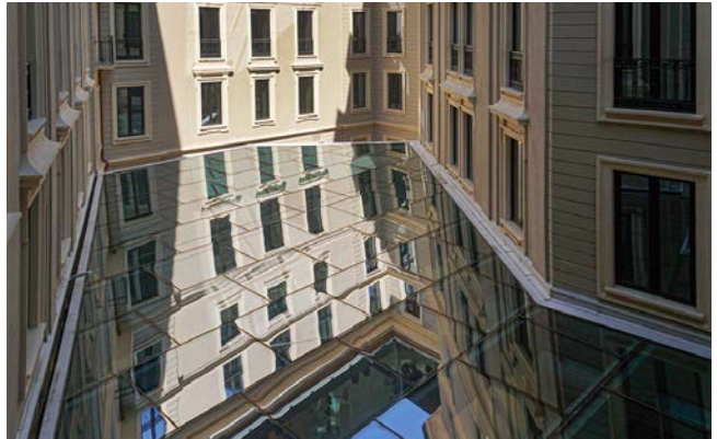
18. La struttura in acciaio con rivestimento in vetro della copertura della corte interna
