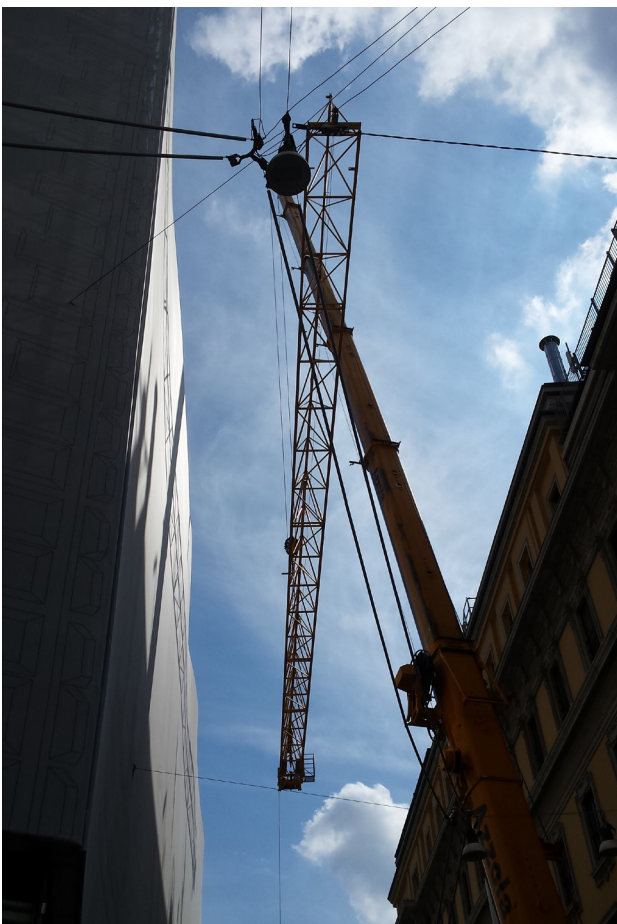
13. Installazione della gru all'interno della corte
