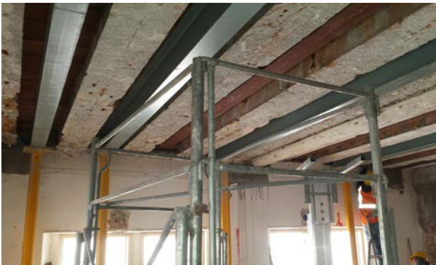
9. Operazioni di rinforzo dei solai dei piani superiori mediante inserimento di nuove travi in acciaio
