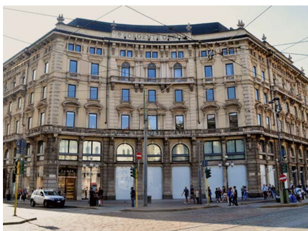
4. Immobile prima dell'intervento di ristrutturazione
