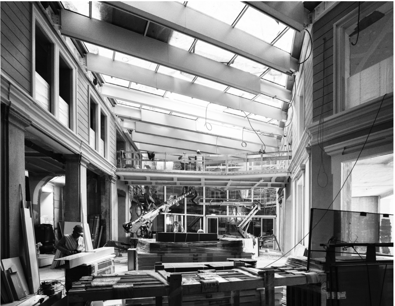
19. Il cantiere della corte interna - © Mario Frusca per Park Associati
