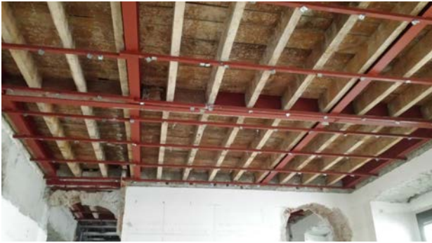
7. Opere di rinforzo metallico dei solai lignei ritrovati durante le operazioni di strip out dei vari ambienti
