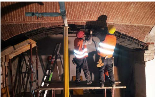
10. Operazioni di rinforzo dei solai a volte in muratura al piano terra
