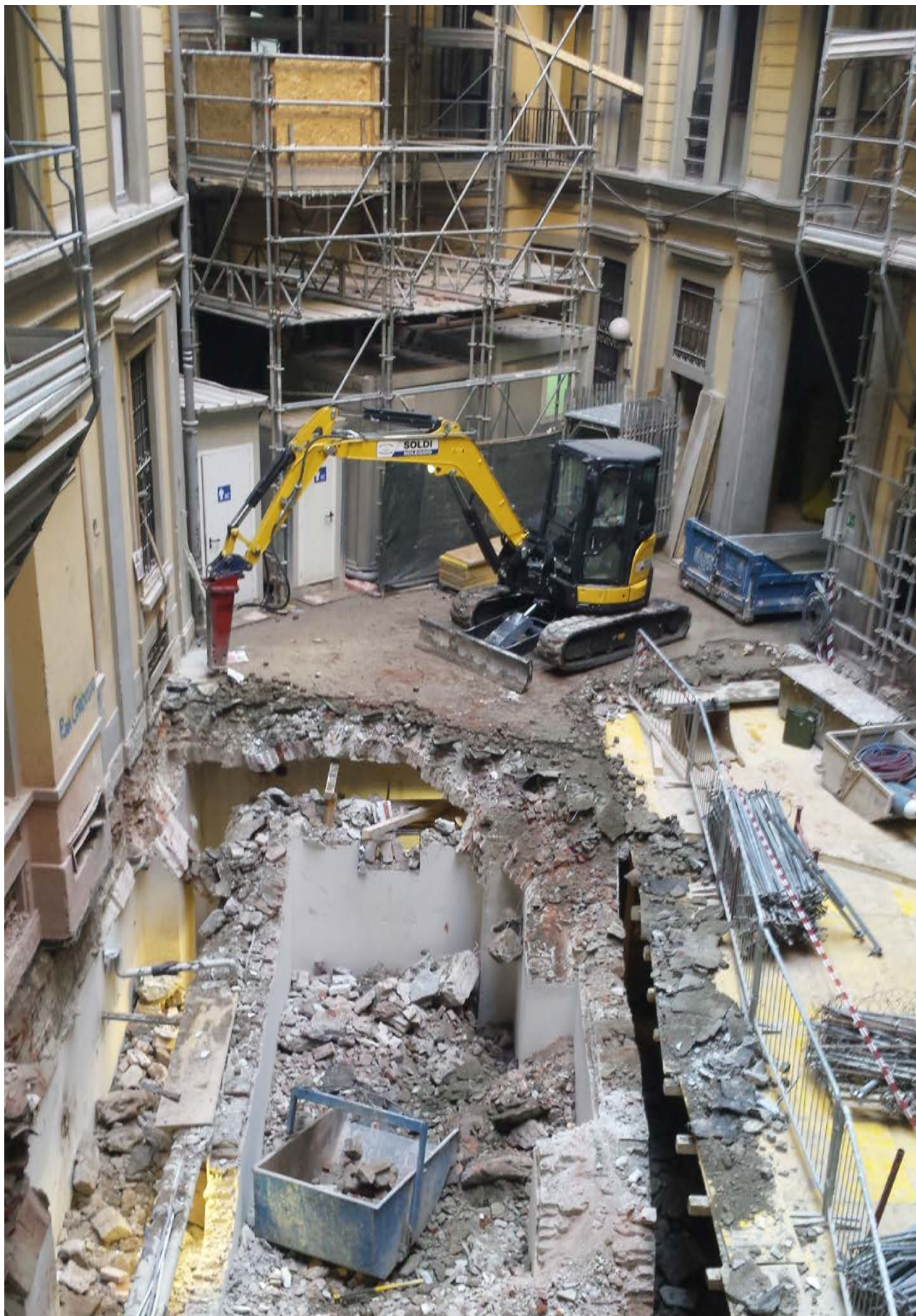
14. L'area oggetto di demolizione
