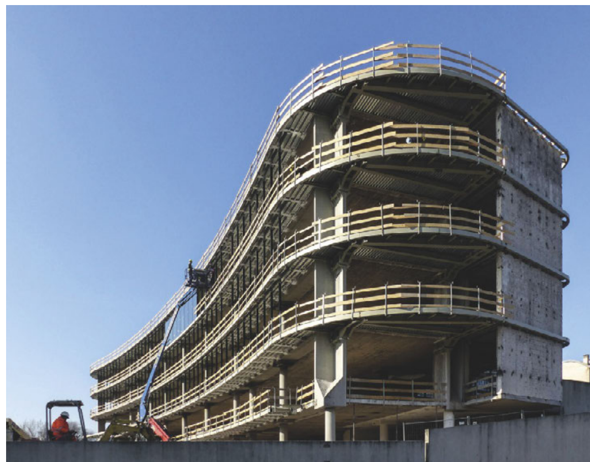
La fase iniziale dell'installazione delle vetrate, partendo dalla fascia centrale in quota del prospetto, ha consentito il controllo dimensionale dei giunti in fase di montaggio. Il cantiere ha previsto una parziale sovrapposizione tra la fase di completamento delle estensioni delle solette e l'inserimento dei primi elementi vetrati in quota The first phase of installing the glazing, starting from the central raised band on the façade, permitted dimensional control of the joints during mounting. The site called for partial overlap between the completion phase of the extensions of the floor slabs and insertion of the first elevated glazed elements
