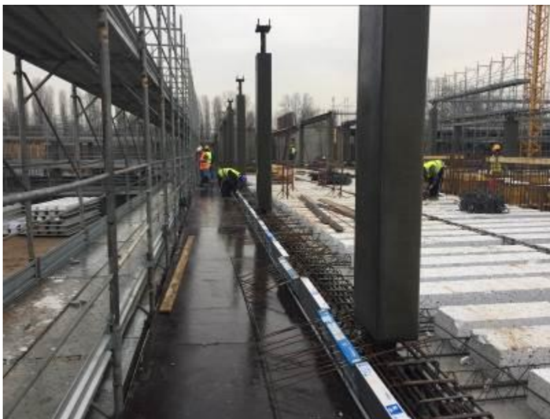
Foto 6 e 7: Alcune fasi della posa in opera dei giunti Isokorb® per la realizzazione delle velette a sbalzo. ©F&M Ingegneria SpA e ©Studio Pession Associato.
