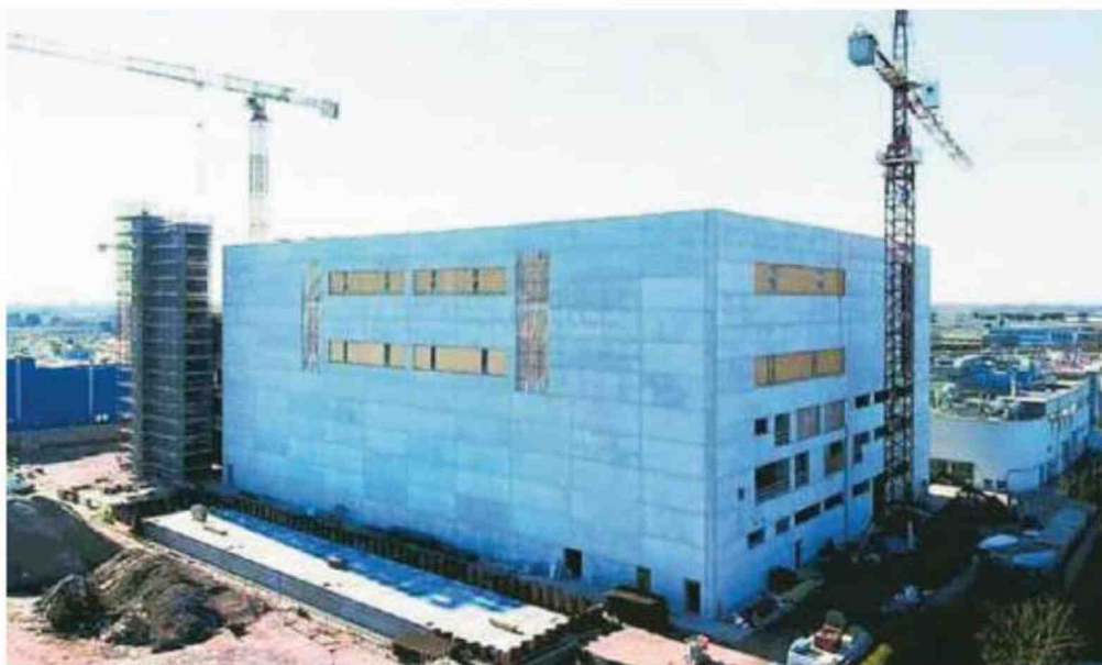
Il nuovo stabilimento in costruzione a Piombino Dese prevede un investimento di 140 milioni di euro
