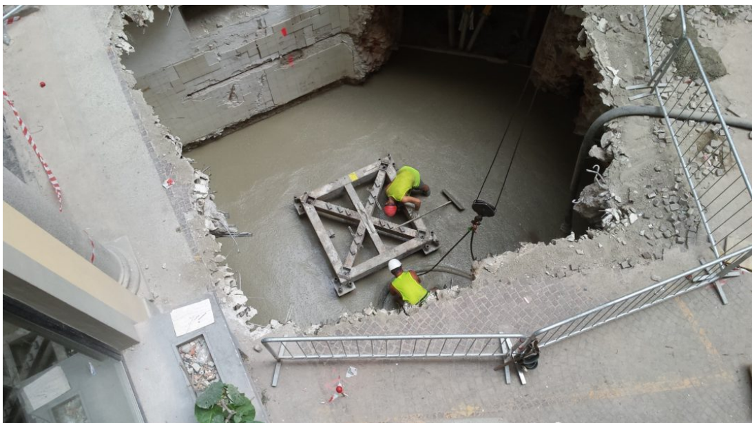
Posizionamento del basamento della gru per la realizzazione del piano interrato | ©F&M Ingegneria
