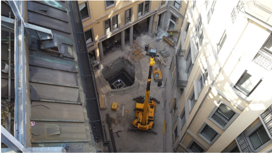
Cortile interno, una delle prime operazioni è stata quella di demolire il solaio per l'inserimento del basamento della gru e della scala di collegamento al piano interrato e piano primo | ©F&M Ingegneria
