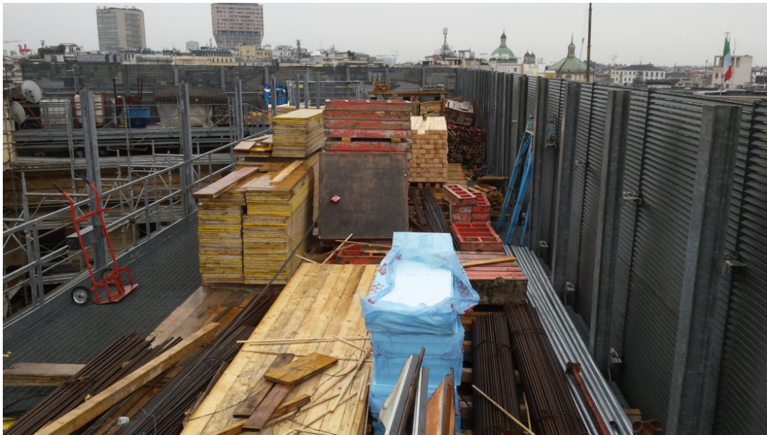
Ricostruzione di solai in acciaio dove non era più possibile recuperare quelli esistenti sia per stato di conservazione sia per i nuovi carichi di progetto | ©F&M Ingegneria
