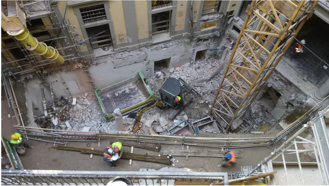
Demolizione della porzione di solaio del piano terra precedentemente utilizzato a cortile, che ha consentito di realizzare il nuovo gruppo scale previsto da progetto | ©F&M Ingegneria
