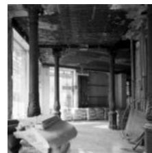
Piano terra, essendo l'area di cantiere praticamente inesistente, ogni spazio è stato sfruttato al massimo per distribuire il materiale necessario alle successive lavorazioni. Tutto è stato gestito fin dalle prime fasi mediante programmazione condivisa tra direzione lavori e general contractor | © Ph. Mario Frusca – Park Associati
