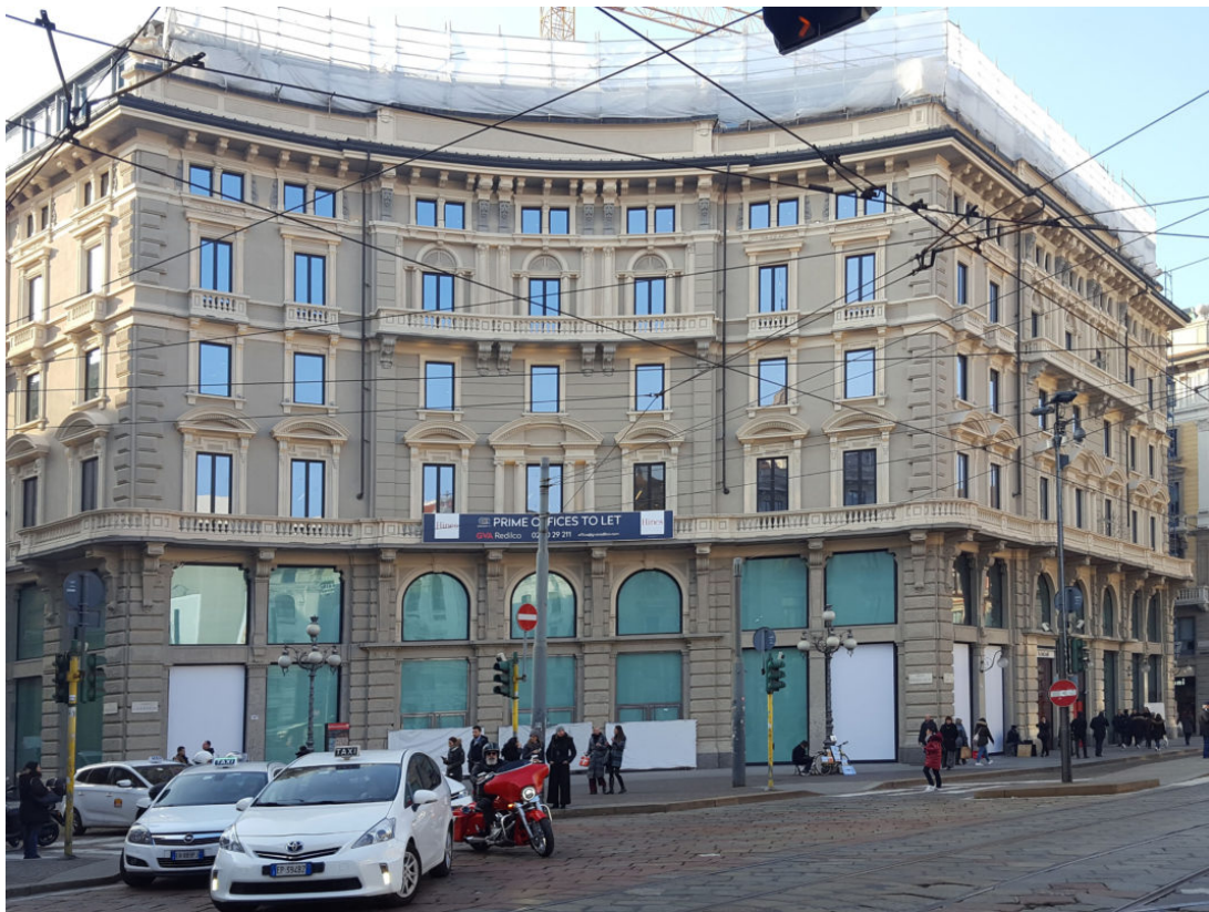
Edificio a lavori ultimati. Le facciate esterne sono state oggetto di semplici operazioni di pulizia | ©F&M Ingegneria
