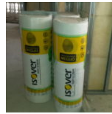
Tutte le pareti esterne sono state coibentate internamente mediante utilizzo di lana Isover rispondendo ai parametri della legge regionale 38/2015 | ©F&M Ingegneria
