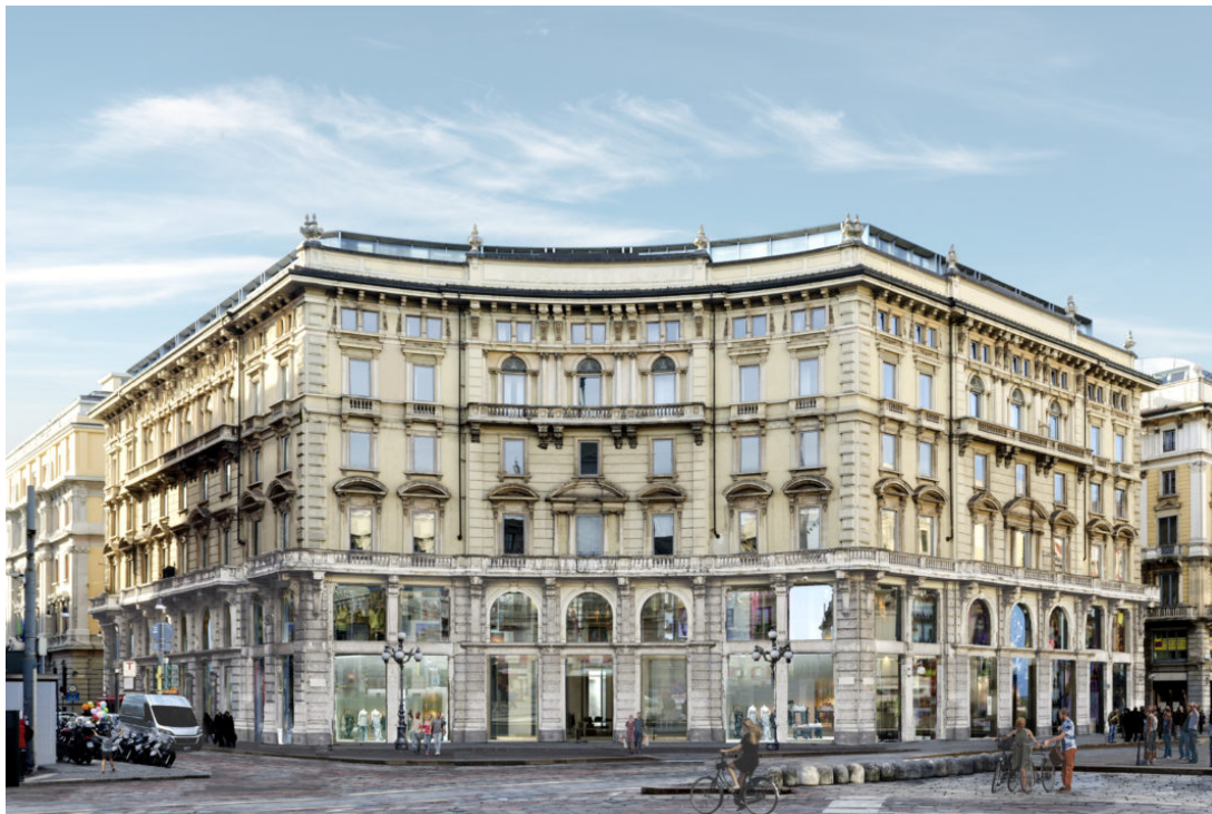
L'edificio visto da piazza Cordusio a lavori ultimati | ©Ph. Mario Frusca – Park Associati
