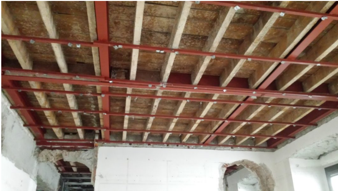
Opere di rinforzo metallico dei solai lignei ritrovati durante le operazioni di strip out dei vari ambienti | ©F&M Ingegneria
