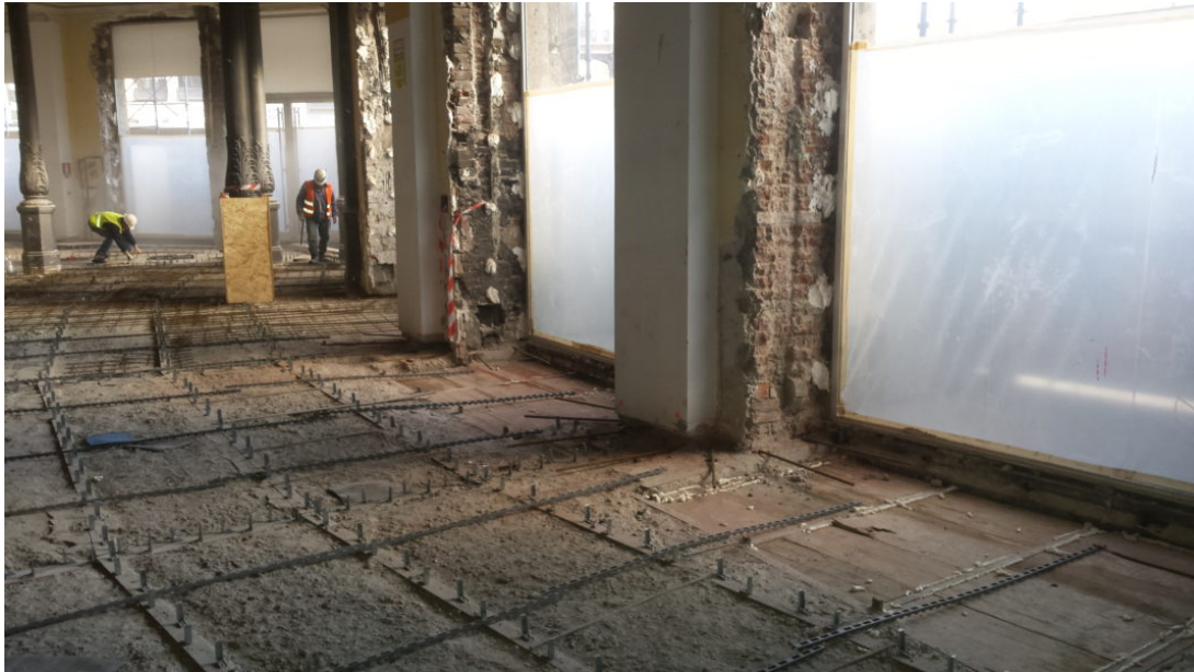
Operazioni di rinforzo del solaio del piano terra mediante getto di calcestruzzo collaborante anche con le strutture verticali | ©F&M Ingegneria
