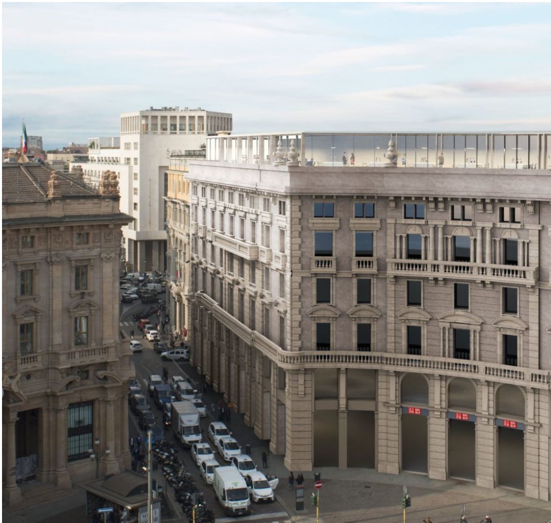
Il nuovo piano di copertura dell'edificio visto da piazza Cordusio | ©Ph. Mario Frusca - Park Associati
