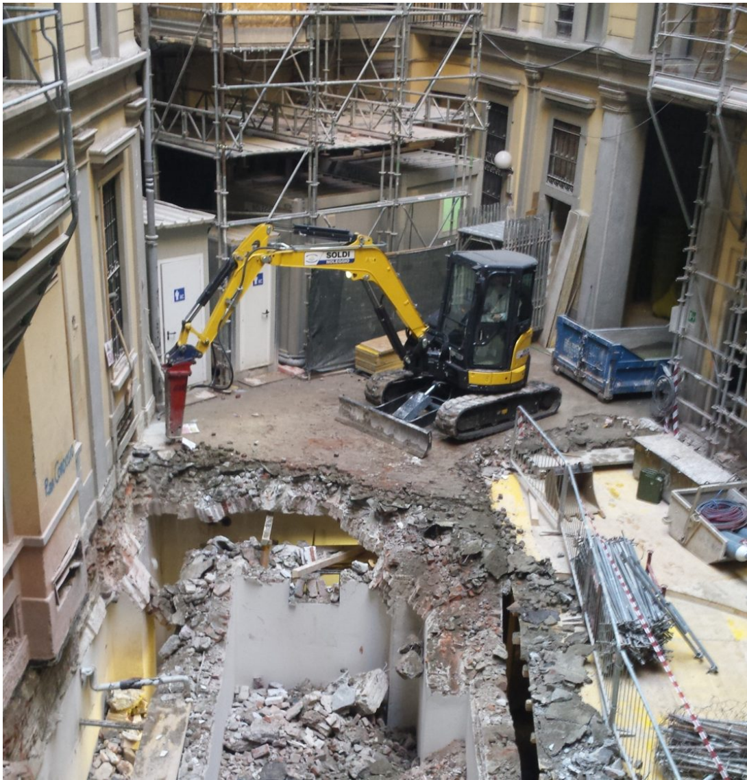
L'area oggetto di demolizione, di dimensioni modeste, ha richiesto l'utilizzo di tecnologie leggere per le operazioni ma efficaci in quanto a tempistiche e risultati attesi | ©F&M Ingegneria
