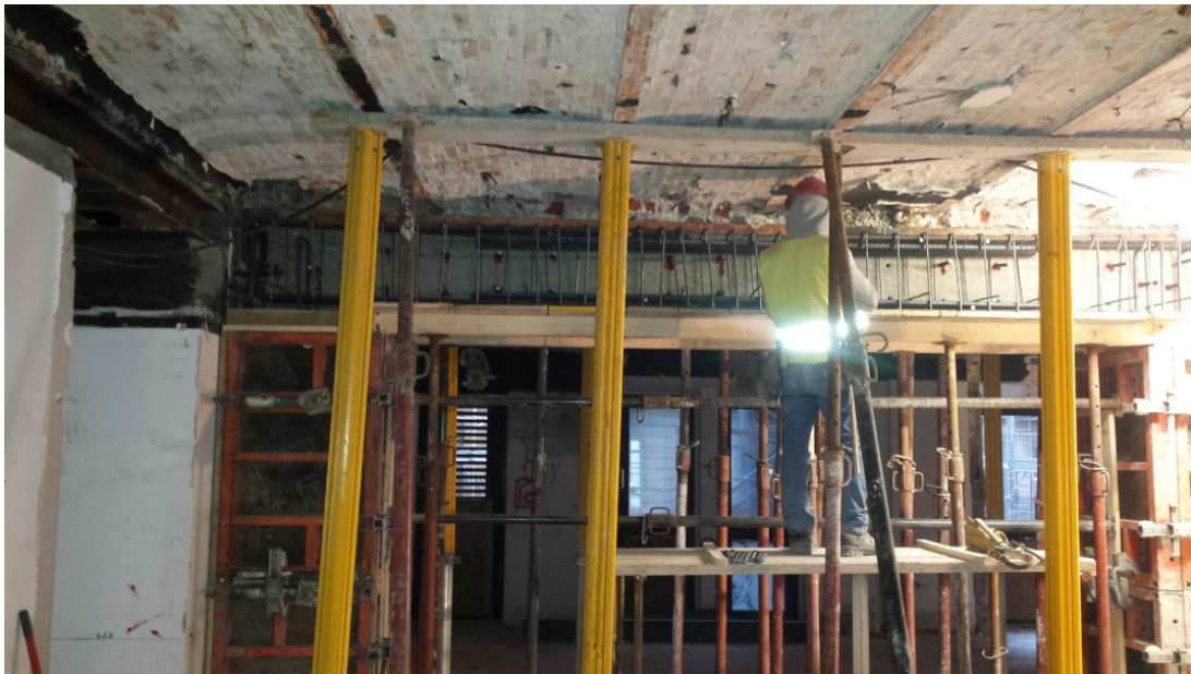
Operazioni di rinforzo dei solai dei piani superiori mediante inserimento di nuove travi in calcestruzzo armato | ©F&M Ingegneria
