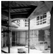
Nuovo solaio del piano terra al posto di quello demolito e sagomato in modo da poter accogliere il nuovo gruppo scala | ©Ph. Mario Frusca – Park Associati
