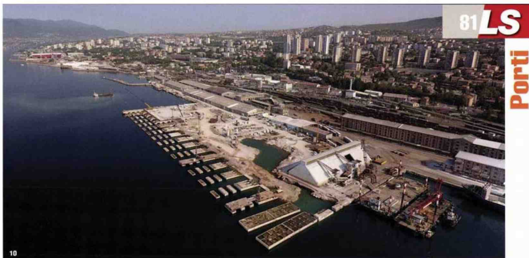
10. Vista del sito durante i lavori
